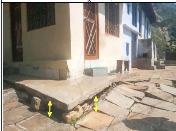
चित्र-9: स्थान-2 पर भूस्खलन के क्राउन भाग में भवन के सतह में स्थित दरारें।
